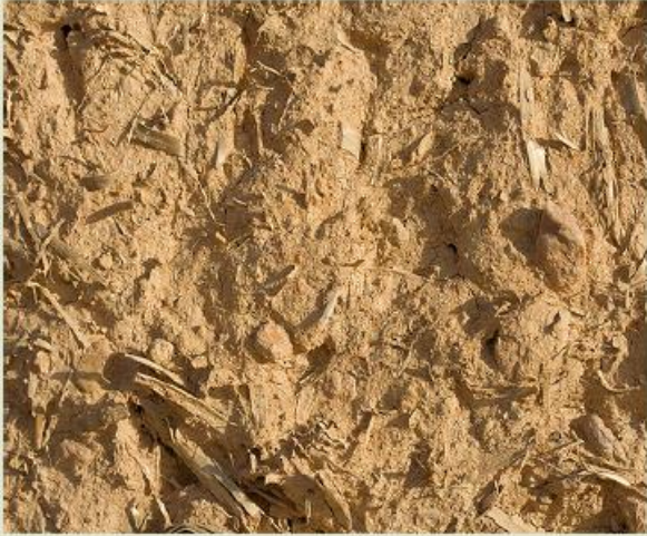
'n Naby-foto van die modder wat gebruik is om die muur te maak.
