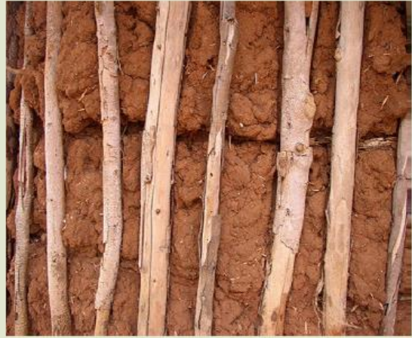
Die muur van 'n modderhuis met 'n stokraam.
